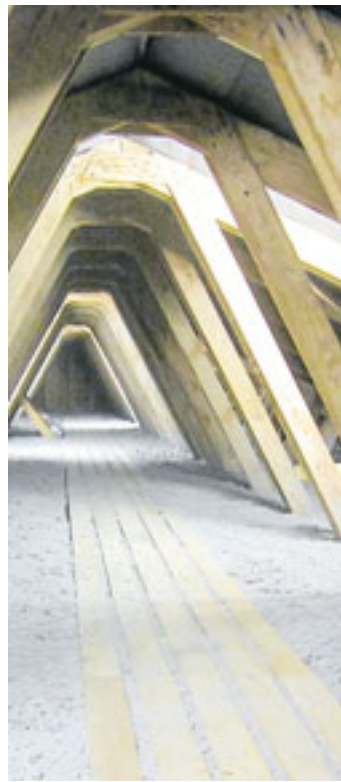
Die Dämmung nicht begehbare Dachböden ist besonders einfach und geht schnell. Die Cellulose-Dämmflocken werden lose über die oberste Geschossdecke verteilt.
